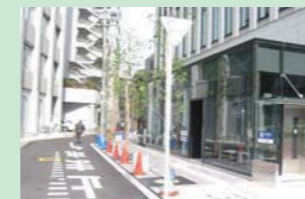
ビル改装による歩道の確保
